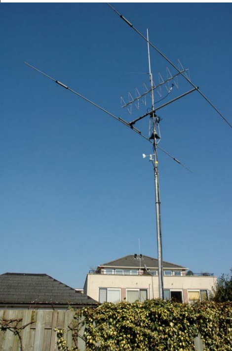
Figuur 2. De mast achterin de tuin met de FB23, een 8-elementen quad voor 2 m (waarover in 2003 een stukje in de Nieuwsbrief heeft gestaan) en de V-2000 in top.
