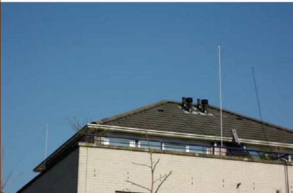
Figuur 1. De twee hulpmastjes. De hoogste (rechts) steekt exact 3 m boven de dakgoot uit, terwijl 5 m is toegestaan. Nog meer naar rechts: de symmetrische twin-lead voedingslijn.
